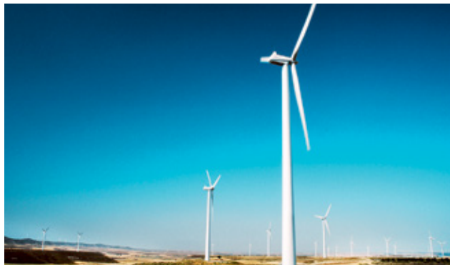
Energía eólica: Se transforma en energía eléctrica en los aerogeneradores (molinos de viento como los de la imagen). Depende de las condiciones meteorológicas, por lo que deben colocarse en zonas con viento frecuente.
