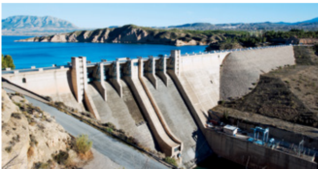
Energía hidráulica: El agua embalsada en lo alto de una presa tiene energía potencial, que cuando cae se transforma en energía cinética y mueve las turbinas de la central hidroeléctrica para producir energía eléctrica.
