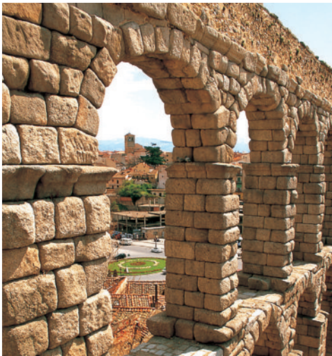
El acueducto de Segovia está construido con 20 400 bloques de granito.
